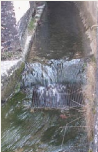
Captage dans le fond du ruisseau
