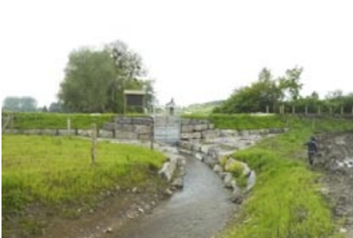
La digue et la vanne de régulation. Vues depuis l'amont.
