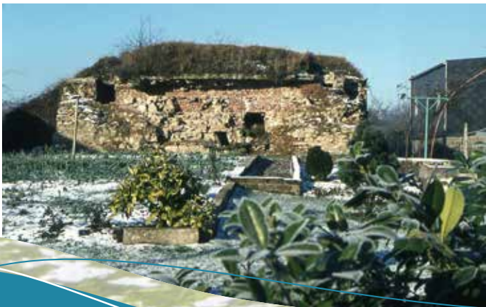
Le château d'eau en voie de démolition (vers 1976).
